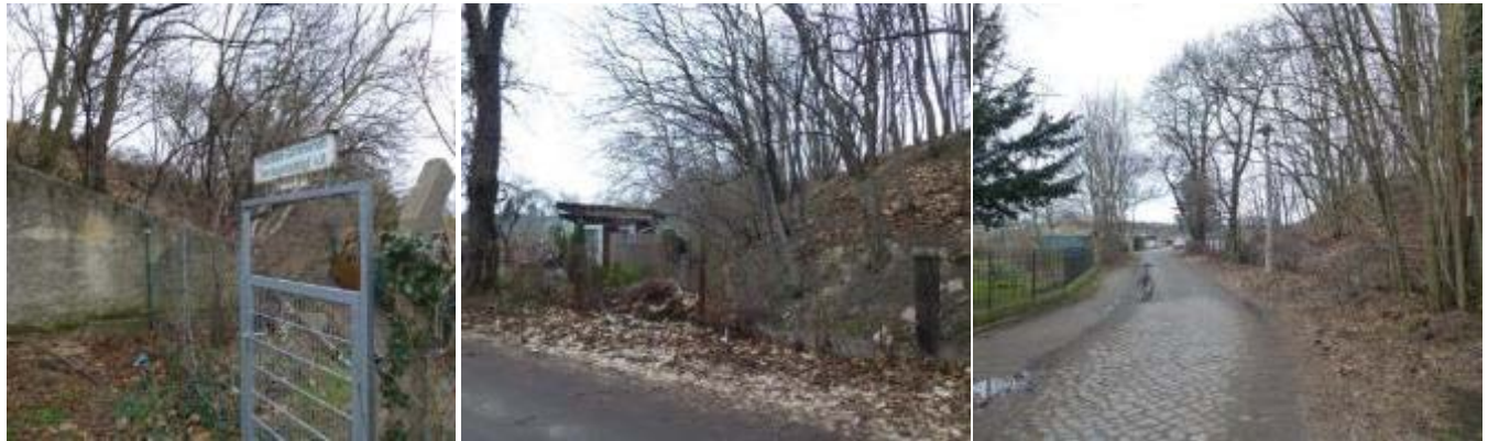
Abb. 7: Situation südlich des Bahndamms zwischen Werderschem Weg und Bahnhof „Am Neuen Palais“
