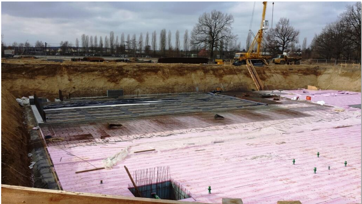
Bild 3: Baumaßnahme der 4 – Feld – Halle/ Leonardo-da-Vinci-Gesamtschule
