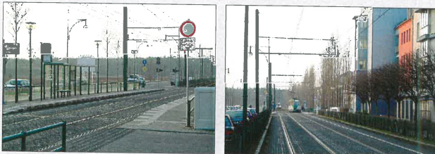
Beispiel Kirchsteigfeld: Haltestelle behindertengerecht, Gleise in Seitenlage
