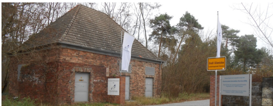
Aufgrund einer geänderten Straßenplanung kann das ehemalige Trafohaus am Nordeingang zur Waldsiedlung stehen bleiben – und wäre ein idealer Standort für Café und Kinderspielplatz.
