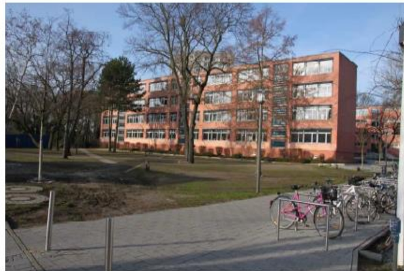
Foto Südseite Längstrakt II
